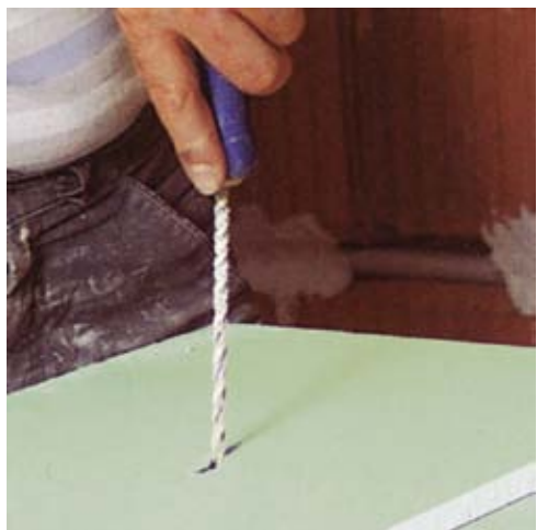
Odprtine za električne doze izrežemo z okroglo rašpo ali vrtnim strojem z ustreznim nastavkom za izrez odprtine.
