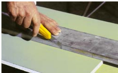
Karton na vidni strani plošče zarezemo ob poravnalni letvi in ploščo prelomimo na robu mize.
